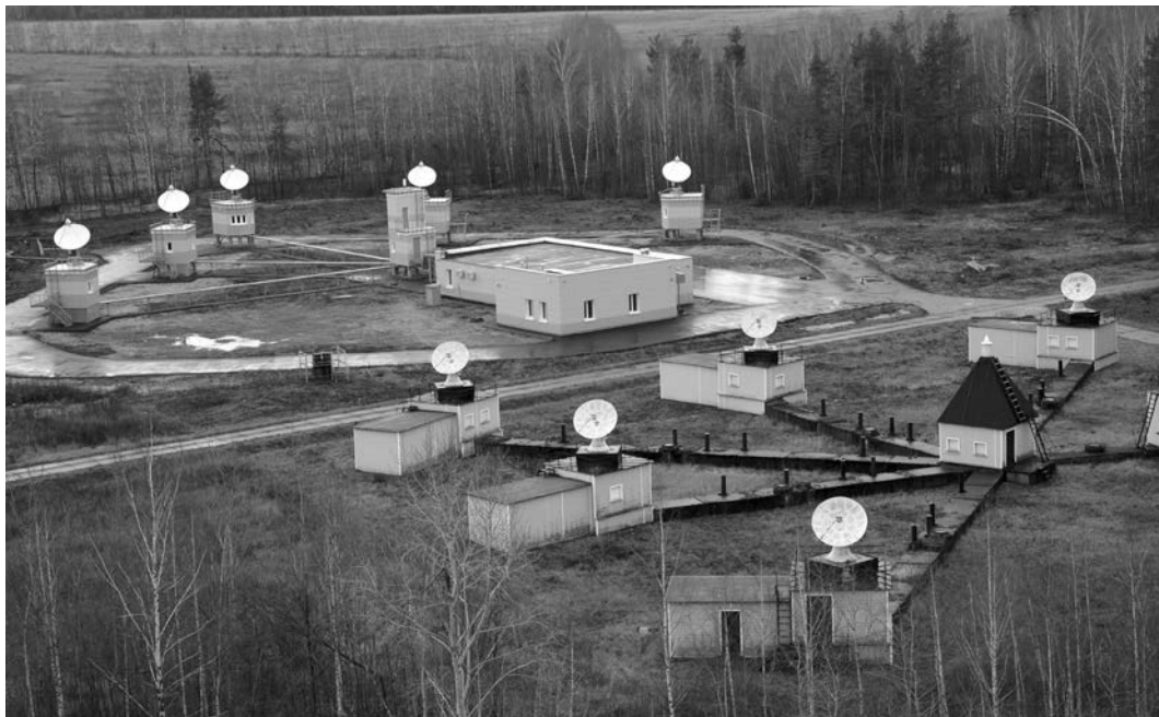
Корреляционно-фазовые пеленгаторы “Ритм” (диапазон 1–4 ГГц) и “Ритм-М” (1–8,5 ГГц), предназначенные для всепогодных высокоточных измерений навигационных параметров космических аппаратов. Пеленгатор “Ритм” введен в эксплуатацию в 1983 г., “Ритм-М” – в 2012 г.
