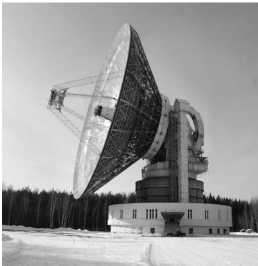
Радиотелескоп ТНА-1500, в настоящее время станция управления межпланетными станциями в дальнем космосе в S-, C- и X-диапазоне. Введен в эксплуатацию в 1978 г. Филиал "Медвежьи Озёра".
