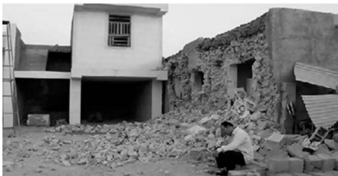
Последствия Иранского землетрясения 9 апреля 2013 г., сопровождавшегося многочисленными афтершоками.
